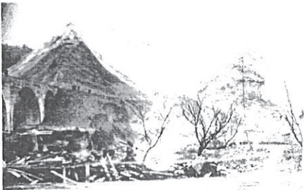
爆発事故により東西に二分割された現場国鉄二又トンネル、点線は爆発前の山形（昭和20.11.14）
