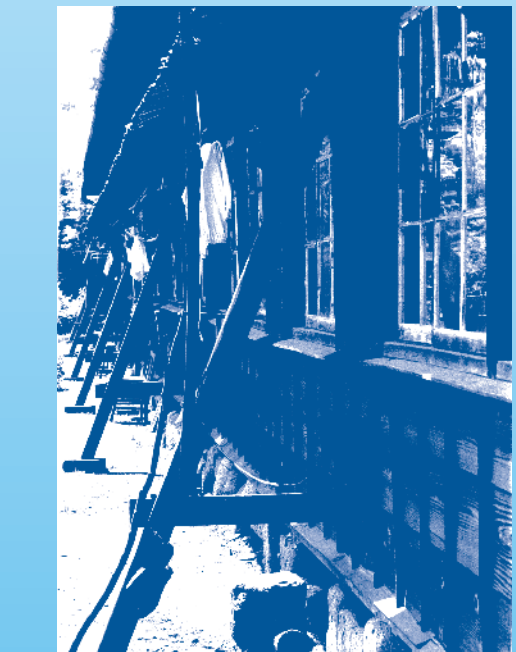
松沢病院 旧病棟
