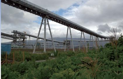
陸前高田市の高上げ工事現場に設置されたベルトコンベア群
